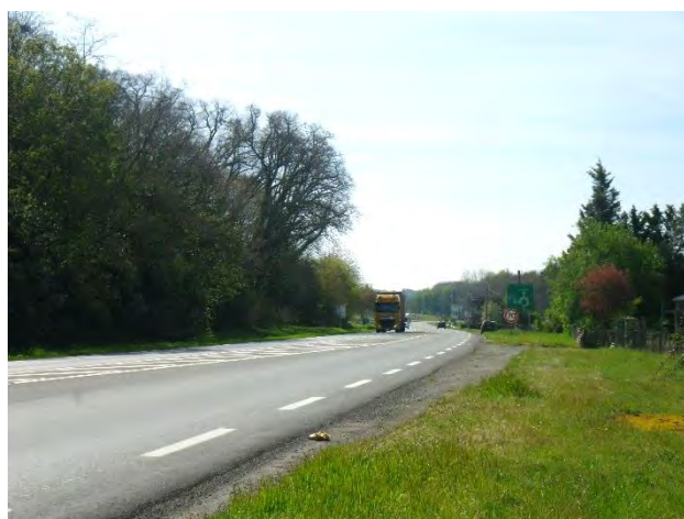
Vue de la RN 10 depuis l'accès actuel au site en direction de Châteaudun
