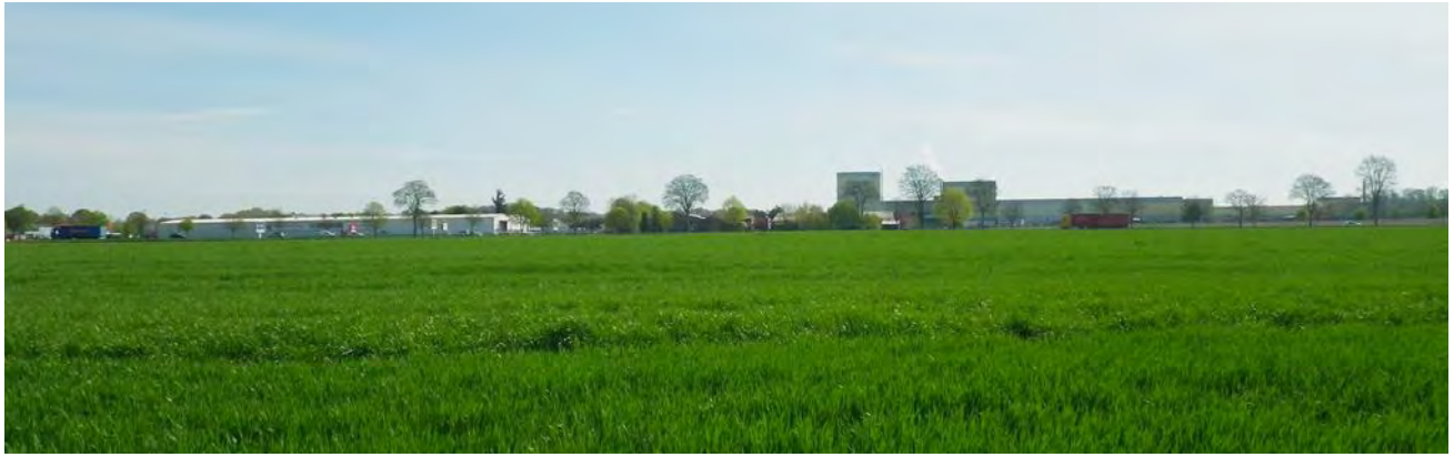
Vue sur la ZI de Marboué (vers l'Est) depuis l'emprise du projet
