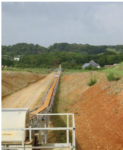
Exemple de tapis qui sera utilisé sur le site de la Guignière
